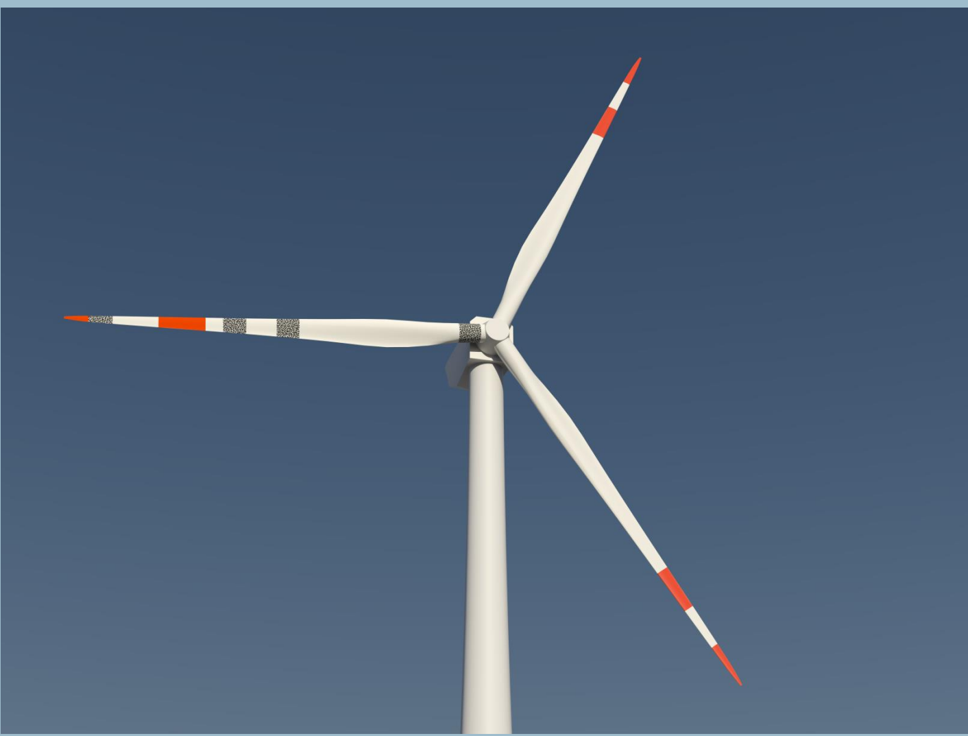
Oben: Detailansicht eines Rotorblattes mit Punktemuster. Links: Windenergieanlage mit aufgeklebtem Punktemuster an einem Rotorblatt. Rechts: Darstellung der Messergebnisse im dreidimensionalen Raum.
